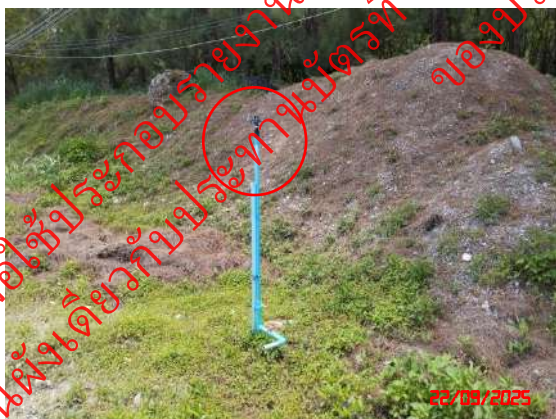
ระบบสเปรย์น้ำบริเวณริมเส้นทางขนส่งแร่
